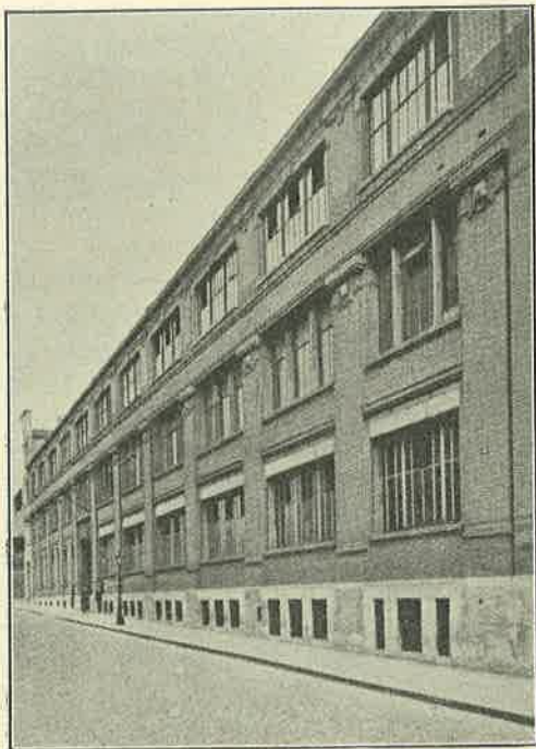
L'atelier en 1924. — Façade sur la rue Charles-Fourier,
