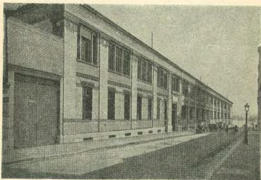
L'atelier en 1907. — Façade sur la rue Charles-Fourier.
