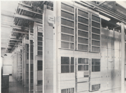
1 - Central automatique Crossbar de filaire Capacité 10 000 lignes
