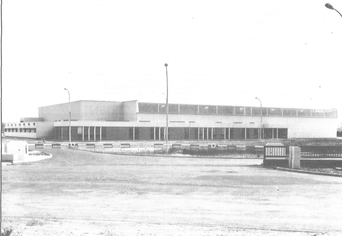
Vue extérieure de l'usine. Etablissement de Morlaix.
